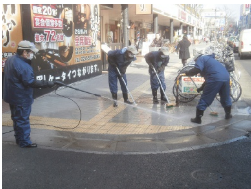
Dekontaminacja śródmieścia przy użyciu sprzętu oczyszczania wysokociśnieniowego. Luty 2012. Zdjęcie: JANIC
