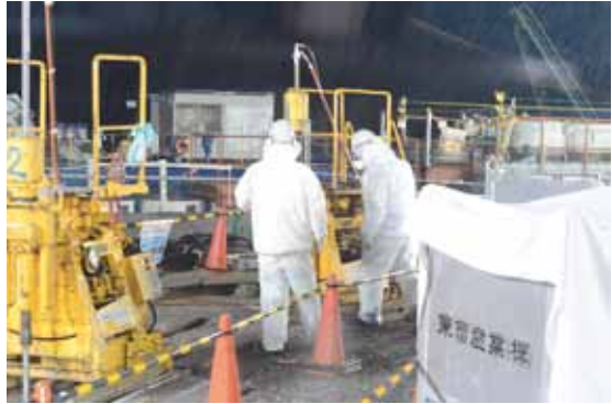
사고 후의 후쿠시마 제1원자력발전소 구내 작업 2013년 7월 촬영
