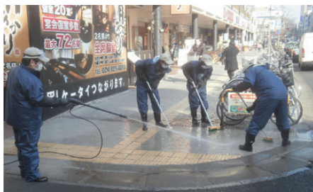
Décontamination de zones urbaines au moyen d'un équipement de lavage à haute pression (février 2012, photo : JANIC)
